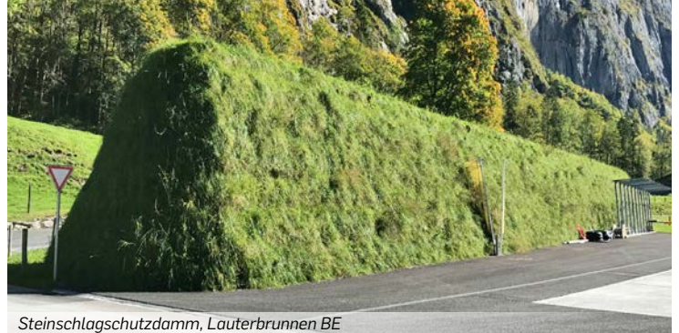
Steinschlagschutzdamm, Lauterbrunnen BE
