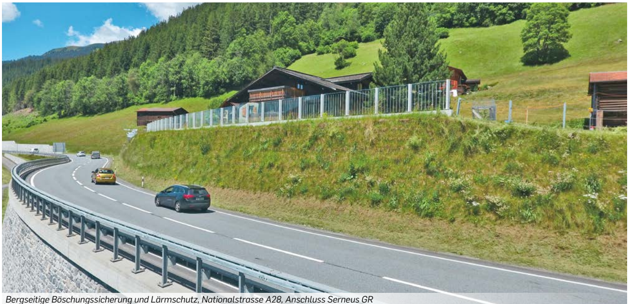
Bergseitige Böschungssicherung und Lärmschutz, Nationalstrasse A28, Anschluss Serneus GR
