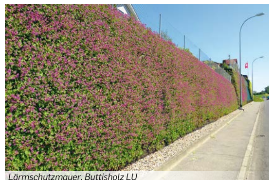
Lärmschutzmauer, Buttisholz LU
