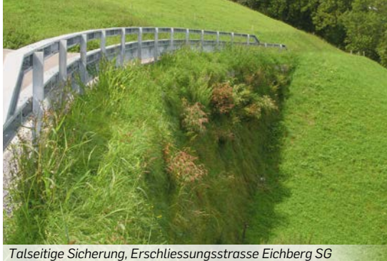
Talseitige Sicherung, Erschliessungsstrasse Eichberg SG
