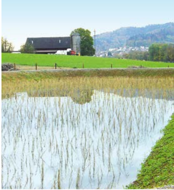
Retentionsfilterbecken
