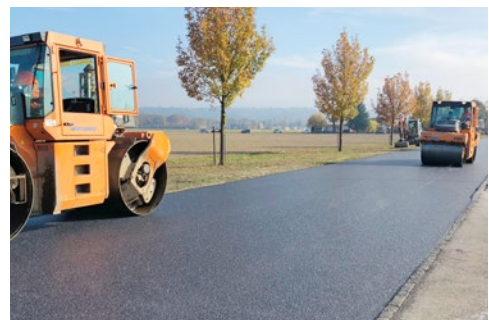
FiberForce®: Hochzugfeste Fasern zur dreidimensionalen Verstärkung des Asphaltbelags
